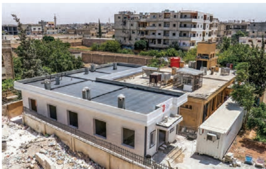
Az épülő máltai kórház Aleppó Al-Nayrab negyedében
