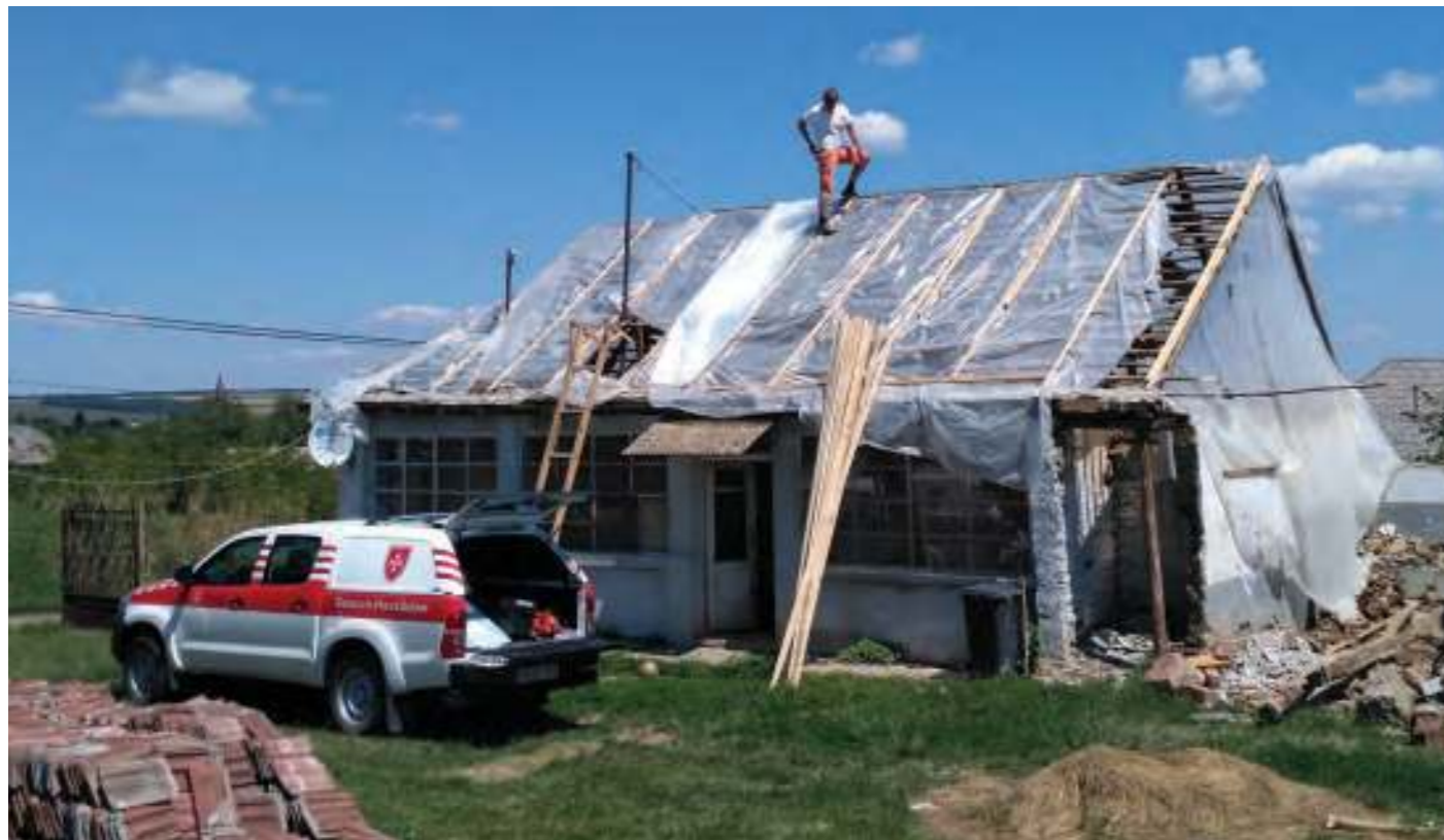
A Szeretetszolgálat mintegy két tucatnyi ház tetőfelújításához járult hozzá (Fotó: Kádár Lőrinc)
